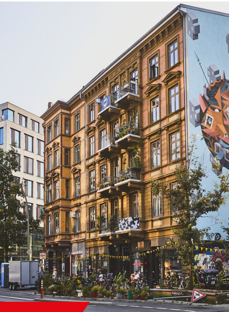
Abb. 46: Blick auf das Gängeviertel © Mediaserver Hamburg / ThisIsJulia Photography
